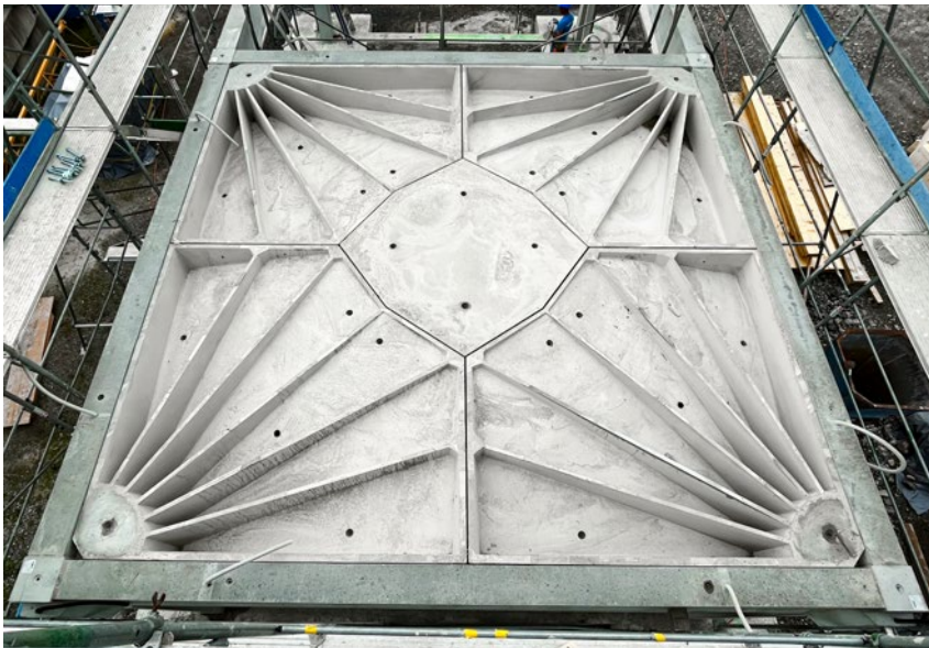
Deckenkonstruktion CreaTower I: Rippmann Floor System (RFS)
