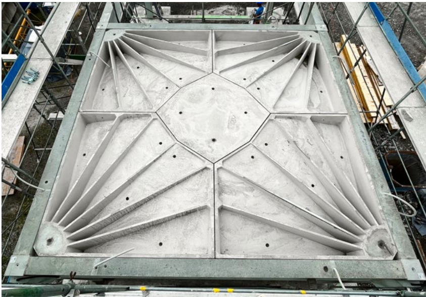
Deckenkonstruktion CreaTower I: Rippmann Floor System (RFS)
